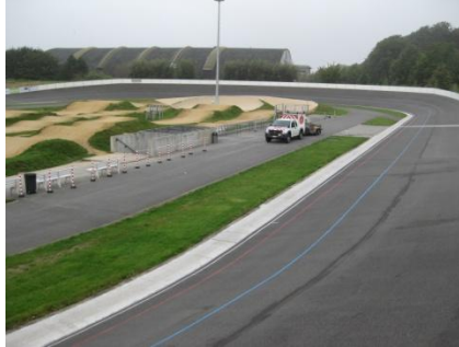
Na het kogelstralen werd de primer aangebracht.
