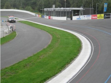
De bestaande verflaag werd verwijderd door stofarm kogelstralen.
