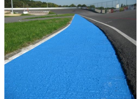
Na het aanbrengen van de primer werd direct Precocryl Rollplastik 2K in RAL 5015 blauw aangebracht.
