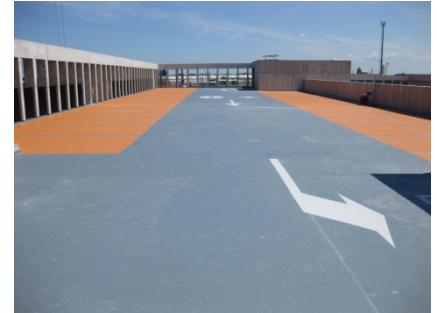
Het afgewerkte parkeerdak!
