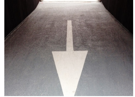
Afwerking van de hellingbaan.
