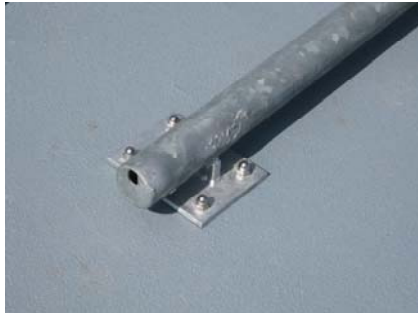
Details zijn bevestigd op de coating
