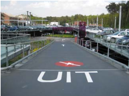
Ook is de hellingbaan voorzien van het Triflex systeem
