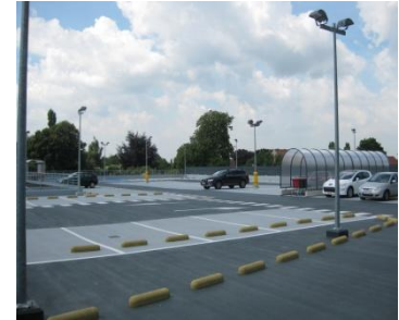
Afgewerkte parking met belijning en markering
