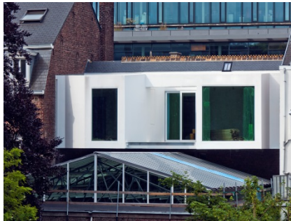
De afwerking met Triflex Finish 205 RAL 9010.
