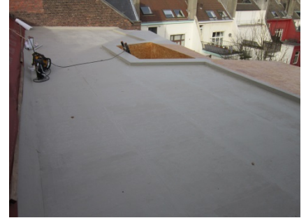
Het aanbrengen van de afdichting op de houten ondergrond (OSB).
