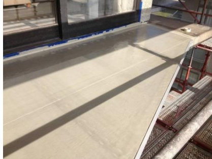
Membraan geplaatst met 5 cm overlap
