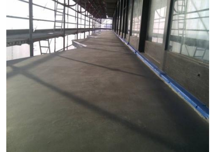
De zelfnivellerende gietvloer na uitharding
