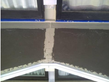
Ingewerkte druipprofielen Uitvlakken van de silex en afdichten van raamdetail
