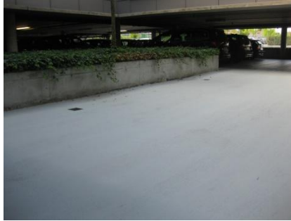
De halfopen binnenparking werd voorzien van een UV-bestendige laag die bestand is tegen binnenvallend daglicht en met voldoende antislip.
