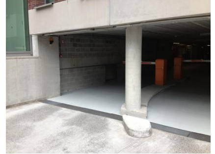
Afwerking aan de in- en uitrit
