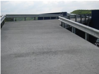
Hellingbaan naar het parkeerdak.
