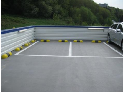
De belijning werd uitgevoerd met Triflex Preco line 300.
