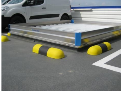
De biggenruggen werden verlijmd met Triflex R238.
