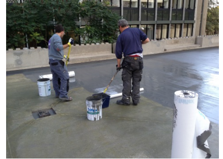
Aanbrengen van de Triflex ProPark membraanafdichting.
