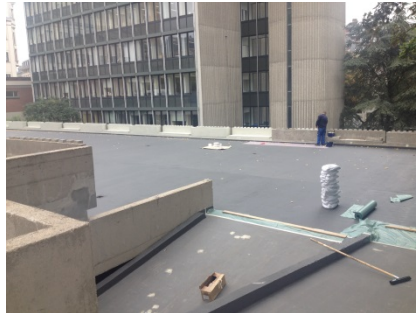
Oprissen en coaten van de muren en de borstweringen met het Triflex ACS systeem.
