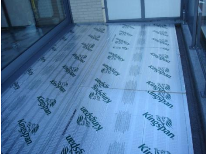
Aanbrengen isolatieplaten
