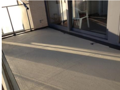
Waterdichting met Triflex ProTerra
