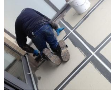
De gietvloer wordt geplaatst.
