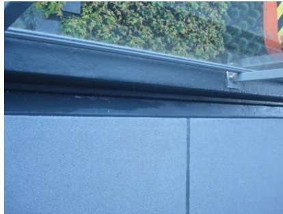
De goten werden mee in het systeem geïntegreerd
