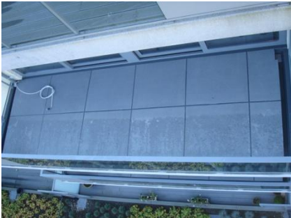
Triflex BTS-S systeem met tegelmotief
