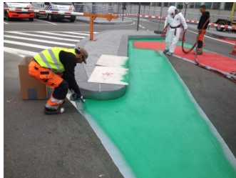
Nadat het product is aangebracht wordt de tape verwijderd.
