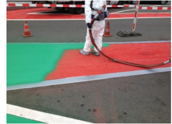
De Kaltplastik SP 3K RAL 6024 wordt gespoten.
