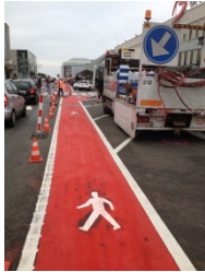
Situatie voor aanvang van de werken en na het reinigen met water onder hoge druk.
