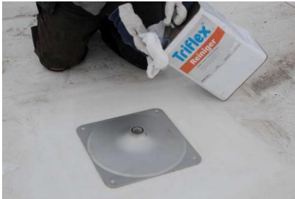
Reinigen van de ondergrond
