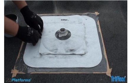
Eerste laag ProDetail en vlies aanbrengen
