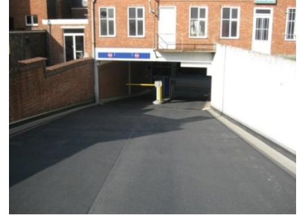
Afgewerkte hellingbaan met het Triflex ProPark variant 3 systeem
