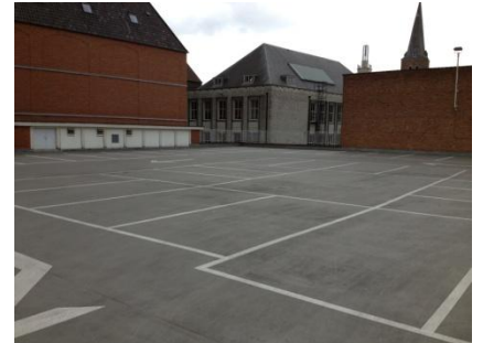
Afgewerkt project met markeringen
