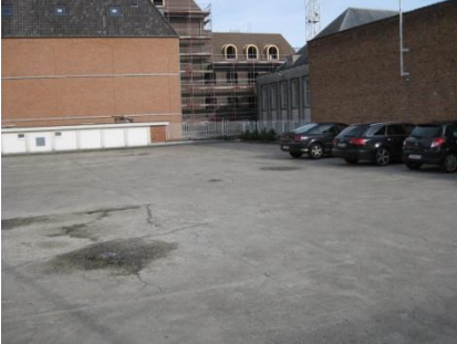
Situatie voor de renovatie
