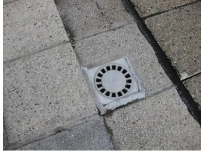
Situatie voor de renovatie - afvoerputje
