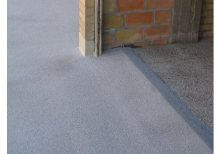
Aansluiting ingang overdekte garage
