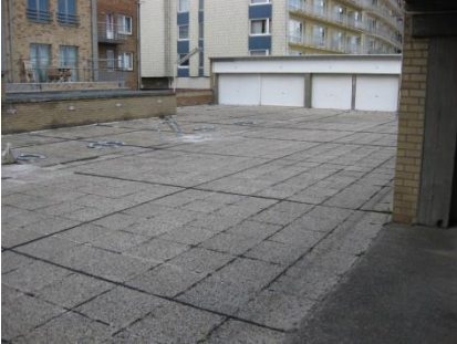
Situatie voor de renovatie
