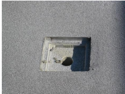
Situatie na de renovatie - afvoerputje
