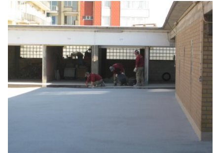
Afgewerkt project met het Triflex PDS-T systeem
