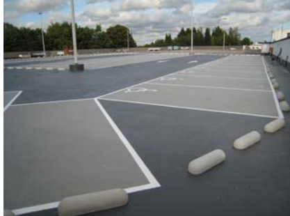
Het parkeerdek na de renovatie
