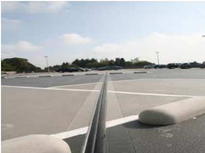
Constructieve dilatatie oplossing
