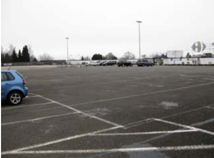
Het parkeerdek voor de renovatie
