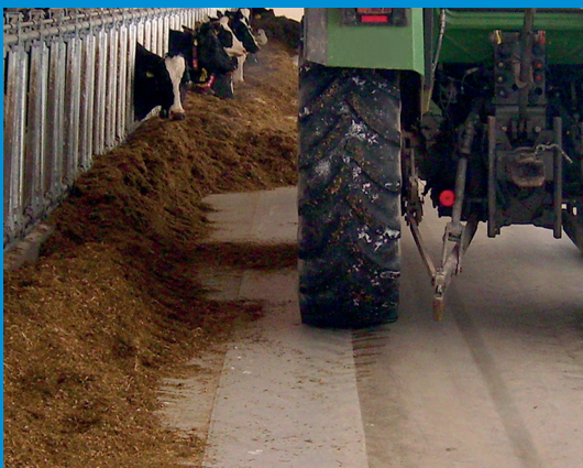
▲ De overgangsvoegen tussen rijwegen en voergangen zijn extra beschermd
