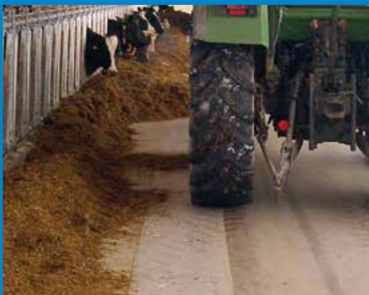
▲ Les joints intermédiaires entre les routes et les couloirs d'alimentation sont spécialement protégés
