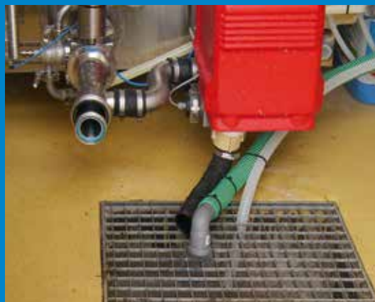
▲ Coating de protection dans le réservoir
