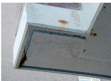
Corrosion par carbonatation. Cette corrosion va entraîner une dilatation de l'armature, laquelle va elle-même entraîner un démemberement du béton.
