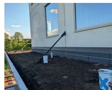
Divese dak afdichtingen
